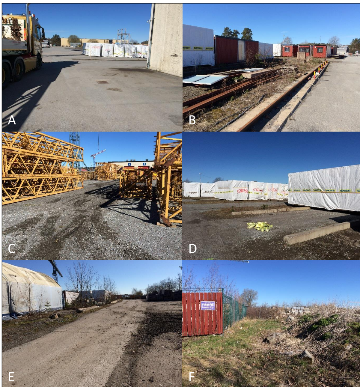
Figur 2-2. Fotografierna A till F visar planområdet från de platser och riktningar som redovisas i Figur 2-1. A: Befintlig dagvattenbrunn, B-D: Lageryta och uppställningsplats samt rester av tidigare tågräls, E: Mindre höjd i områdets sydvästra del, F: Mindre del naturmark i öster.
